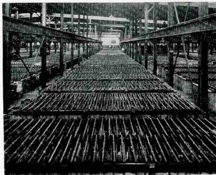
FIG. 33. — Affinage électrolytique du nickel, Port Colborne (Canada).
